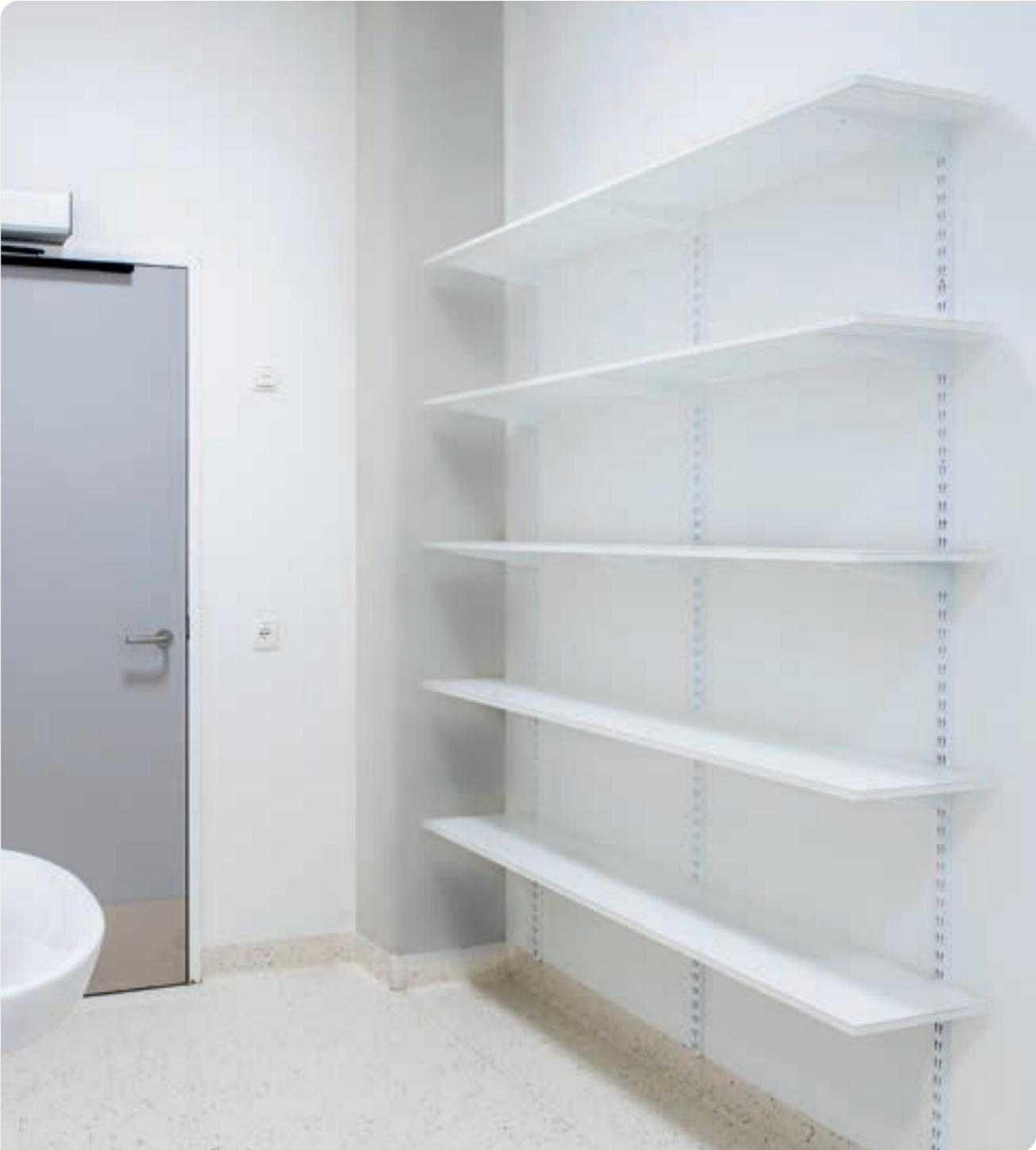
*Repisas ajustables en altura y montadas en pared*
